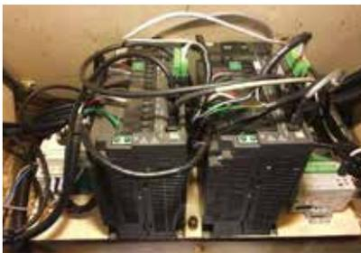
รูปที่ 3 ชุดควบคุมของระบบแท่นยิงจรวดแบบปิดด้วย PLC (ติดตั้งภายในยานพาหนะ)
