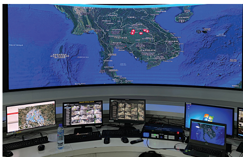
รูปที่ 12 ห้องควบคุมเชื่อมต่อแพลตฟอร์มโครงข่ายกล้องอัจฉริยะด้วยโปรแกรม Pineapple ตำรวจภูธรภาค 4
